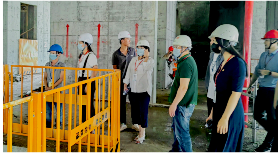
在建大楼安全巡查
